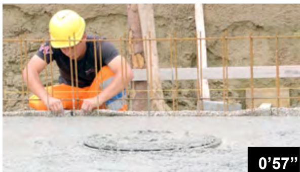
Incorporation des bandes BFL-Mastix dans le béton frais d'un radier
