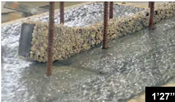
Pose des bandes BFL-Mastix type R4
