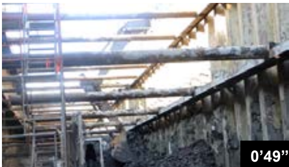
Etanchéité des joints du bassin Marc Aurèle Fortin
