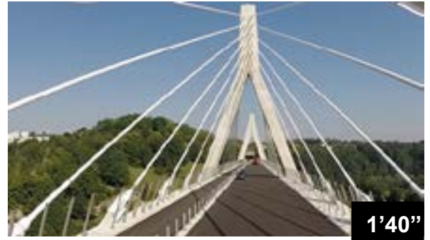
Waterproofing curbside joints on the « la Poya » bridge
