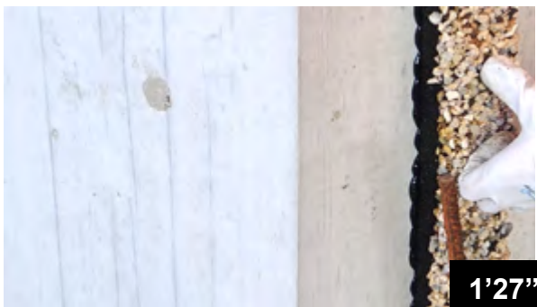
Vertikales Kleben der BFL-Mastix Bänder Typ R4 1/2 D
