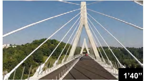
Wasserdichtung der Ranfugen der «Poya» Brücke
