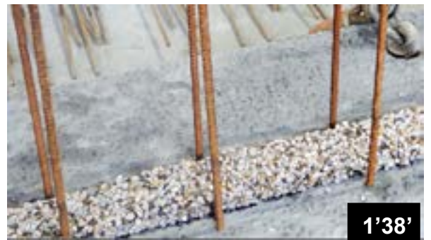
Horizontales Verkleben von BFL-Mastix Bändern Typ R
