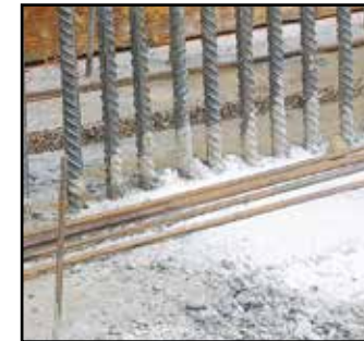
BFL-Mastix Bänder im Beton der Bodenplatte verlegt
