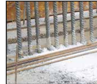
BFL-Mastix Bänder im Beton der Bodenplatte verlegt
