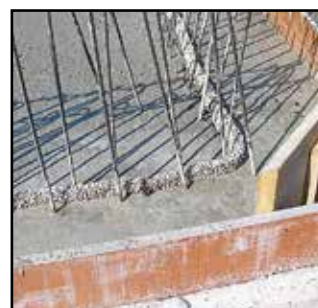
In den Ecken werden die Bänder abgebogen
