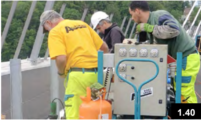
Etanchéité des joints de bordure sur le Pont de la Poya
