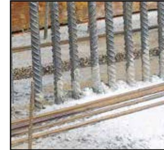
Bandes **BFL-Mastix type R4** incorporées dans le béton du radier
