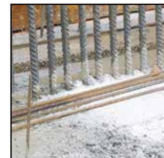
Bandes **BFL-Mastix type R4** incorporées dans le béton du radier
